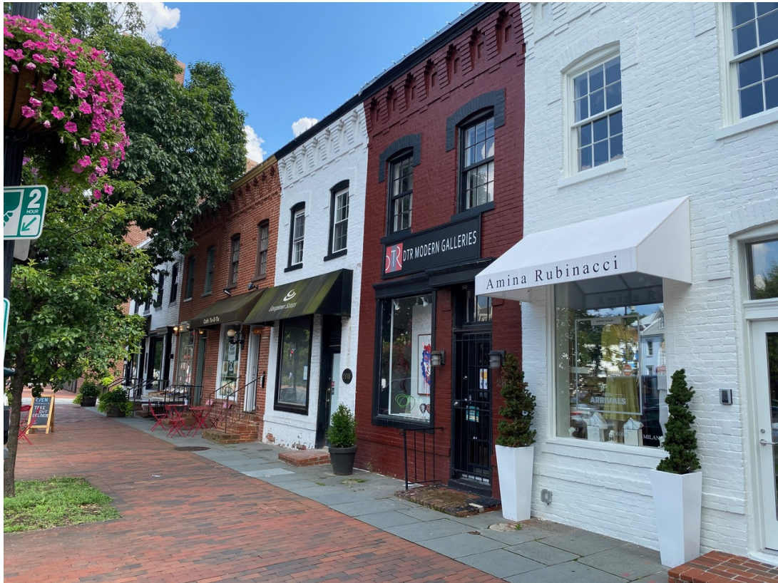
STREET FACADE (OBLIQUE)
