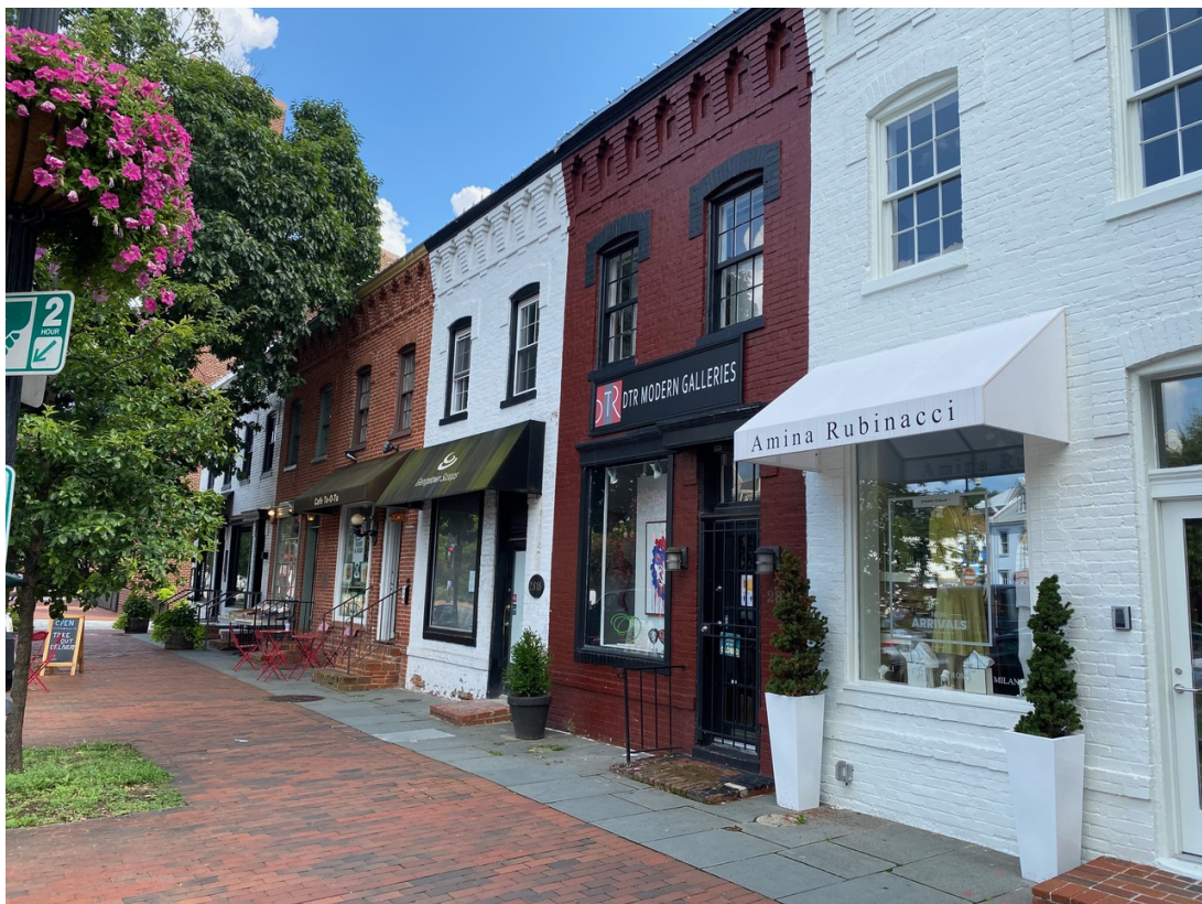
STREET FACADE (OBLIQUE)
