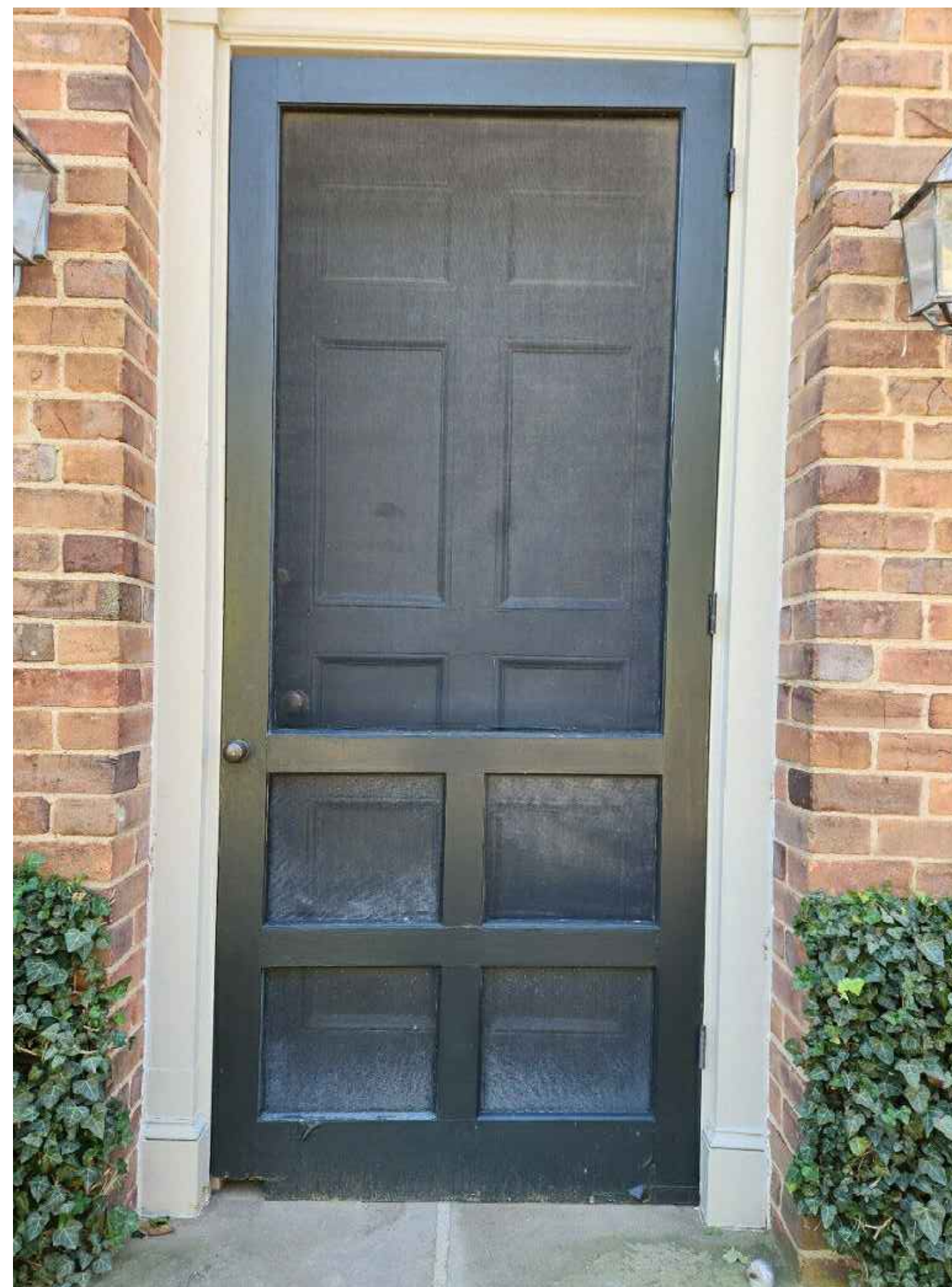
4 PAVILION EXISTING DOOR NTS
